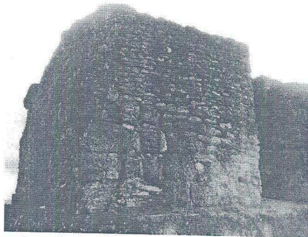
Foto 5. Esquina Noroeste, Cámara del Edificio 216
